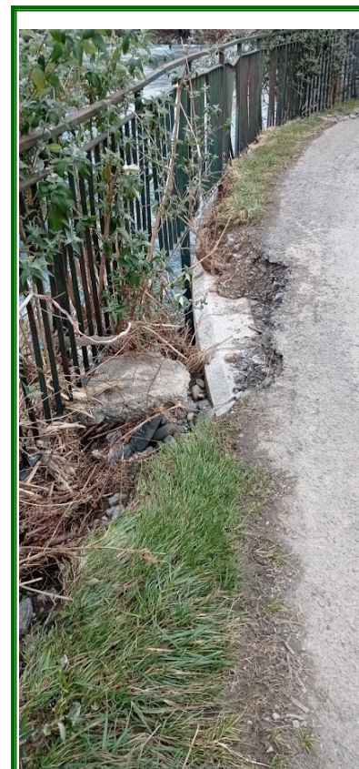
LE PONT DU GAVE avant
